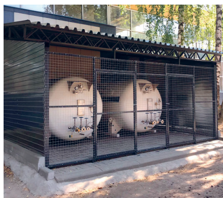
Размещение криогенных цистерн
