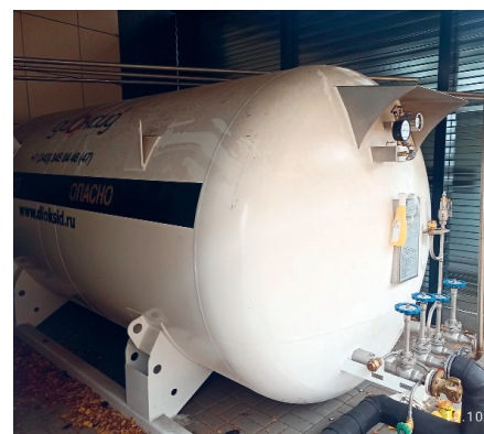
Криогенные цистерны подключены к климатической камере
